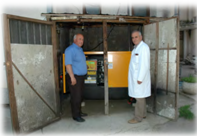
Ospedale di Silovo, il generatore donato da ALS (aprile 2011)
