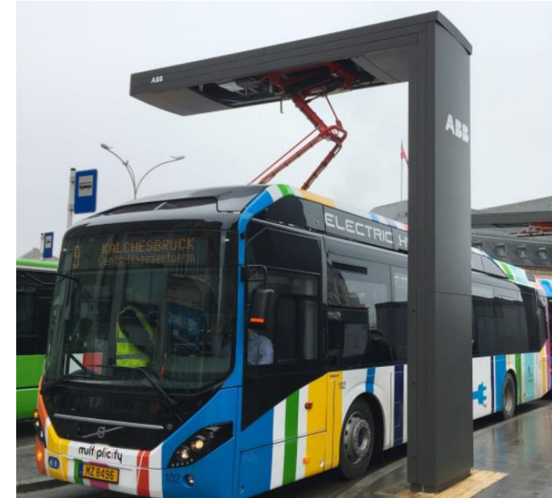
Esempio di ricarica elettrica attraverso pantografo
