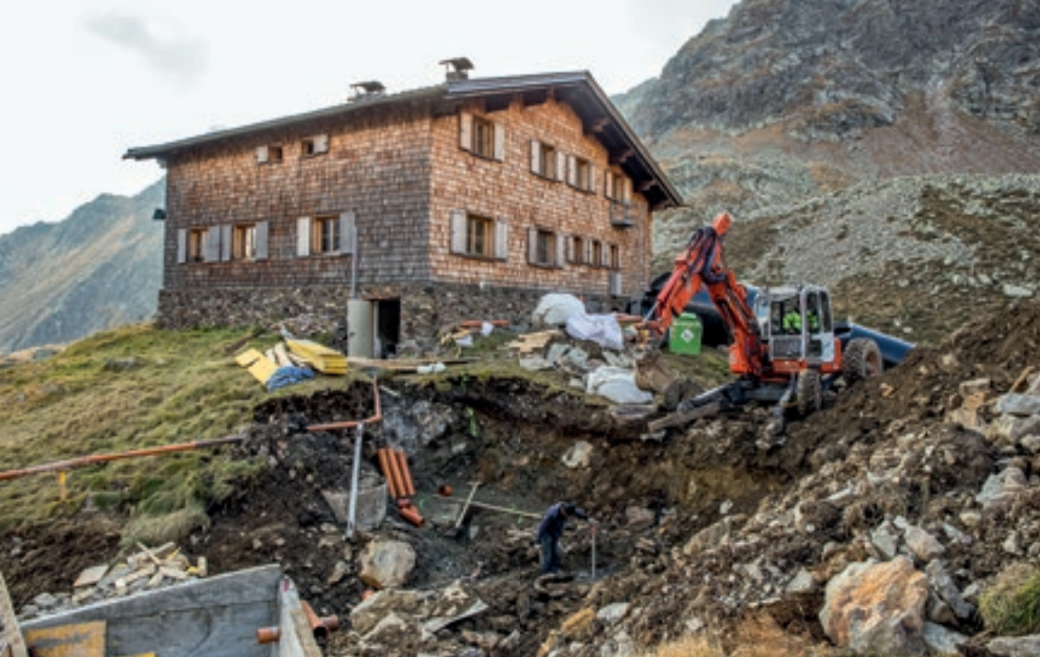
Sanierung der Kläranlage der Tiefrastenhütte
